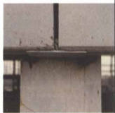
钢结构外墙横板 专用托板示例图
