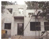
砌块低层承重结构工程示例图
