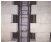
构造柱预留钢筋示例
